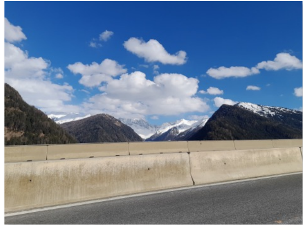
TALBLICK BRENNERAUTOBAHN A13 > SCHMIRN- / VALSERTAL, AM 05.04.2023
