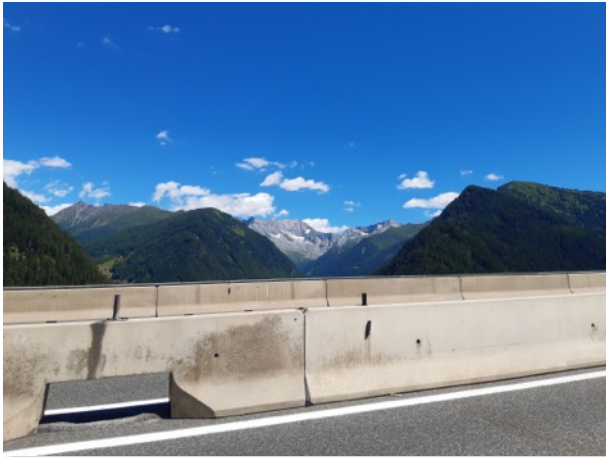
TALBLICK BRENNERAUTOBAHN A13 > SCHMIRN- / VALSERTAL, AM 12.07.2022
