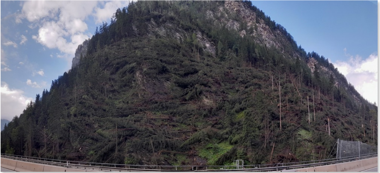
BRENNERAUTOBAHN A13 - LUEGBRÜCKE | TIROL - 27.07.2023 KOMPLETTES WALDGEBIET VERWÜSTET, NACH EINEM HEFTIGEN STURM
