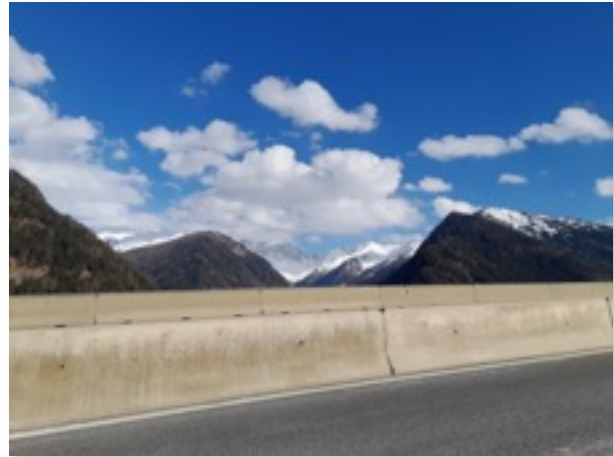
TALBLICK BRENNERAUTOBAHN A13 › SCHMIRN- / VALSERTAL, AM 05.04.2023
