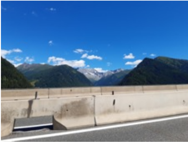
TALBLICK BRENNERAUTOBAHN A13 › SCHMIRN- / VALSERTAL, AM 12.07.2022
